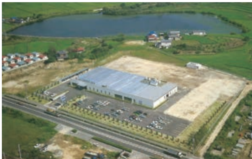
シャープタカヤ電子工業設立直後の工場全景(1979年)
