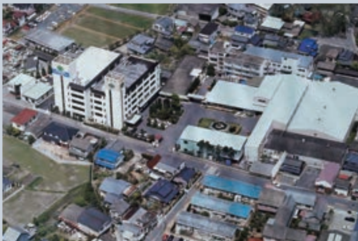
新社屋建設のころ(1988年)
